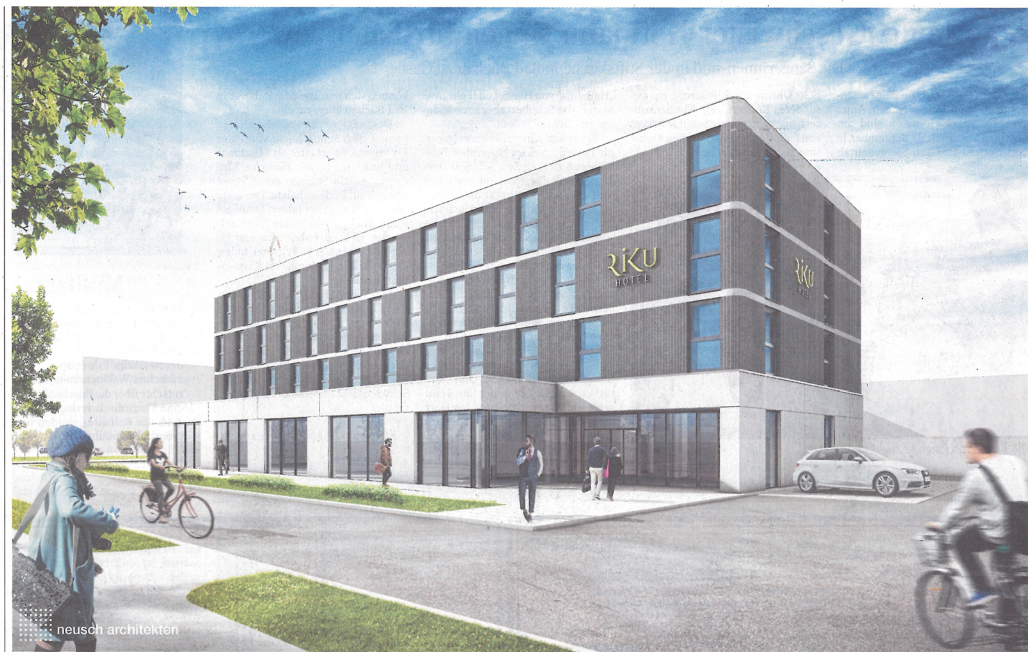
Trotz klarer Vorgaben eine reizvolle Aufgabe: der Hotel-Neubau auf dem ehemaligen Bahnareal in Pfullendorf.
